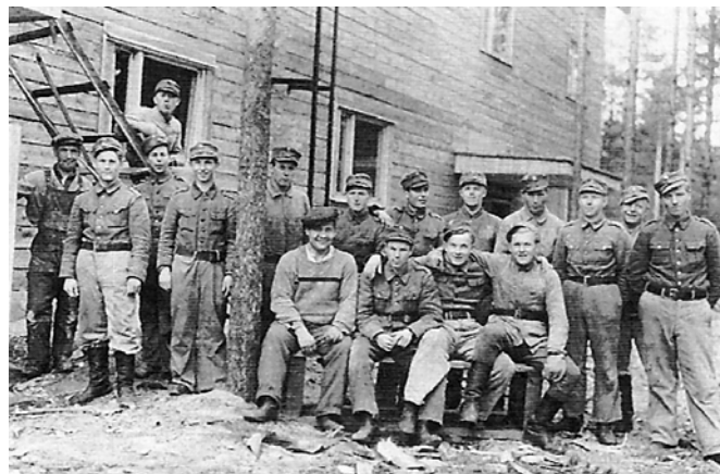
Puolustusvoimien Rakennustyökomppania rakenteilla olevan ”susitalon” edessä.
